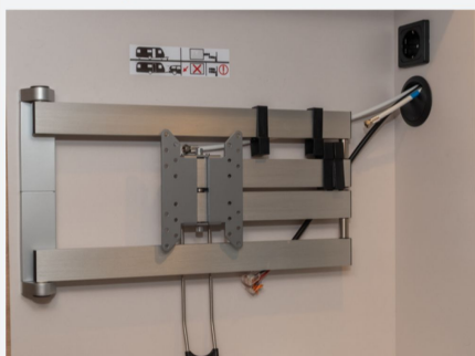
TV-Vorbereitung mit Steckdose und Kabelverlegung/-durchführung
