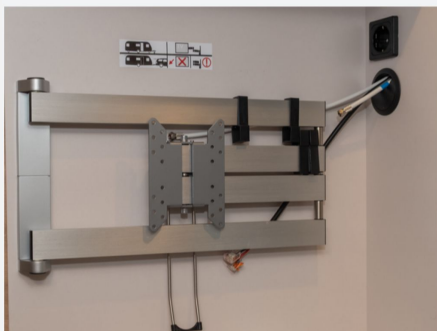
TV-Vorbereitung mit Steckdose und Kabelverlegung/-durchführung
