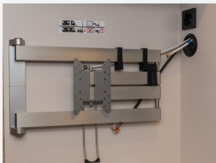
TV-Vorbereitung mit Steckdose und Kabelverlegung/-durchführung
